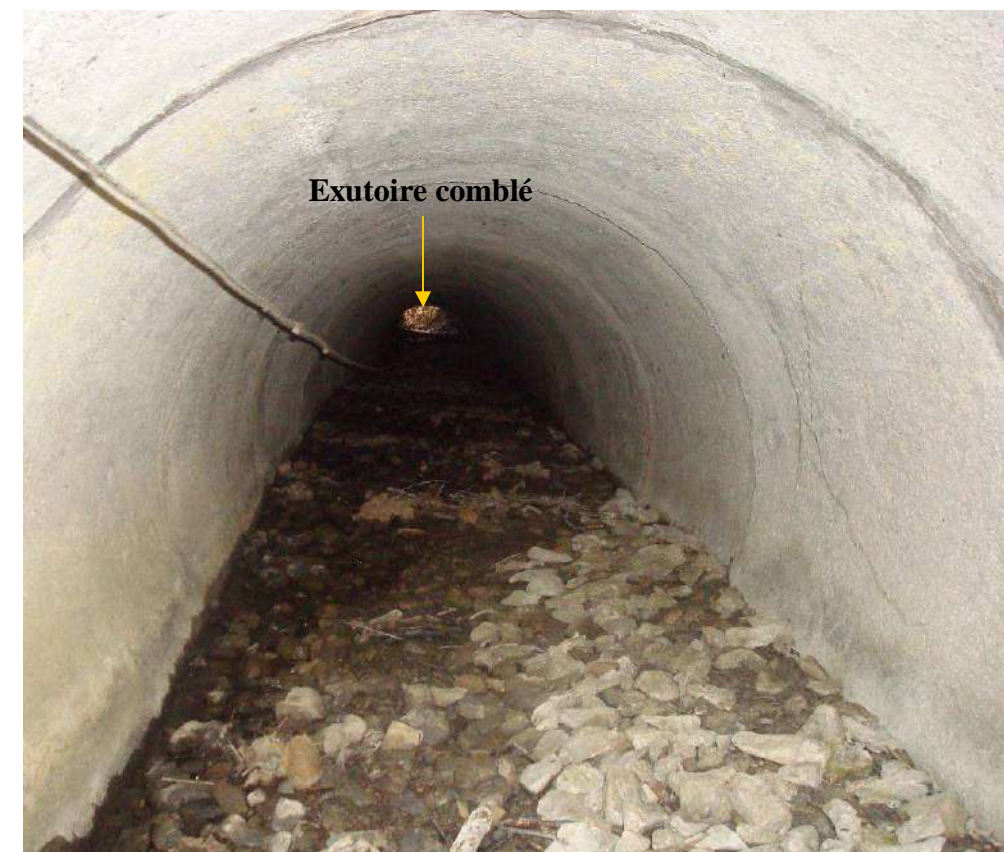
Canalisation de 1000 mm lors de la traversée de la RD 80
