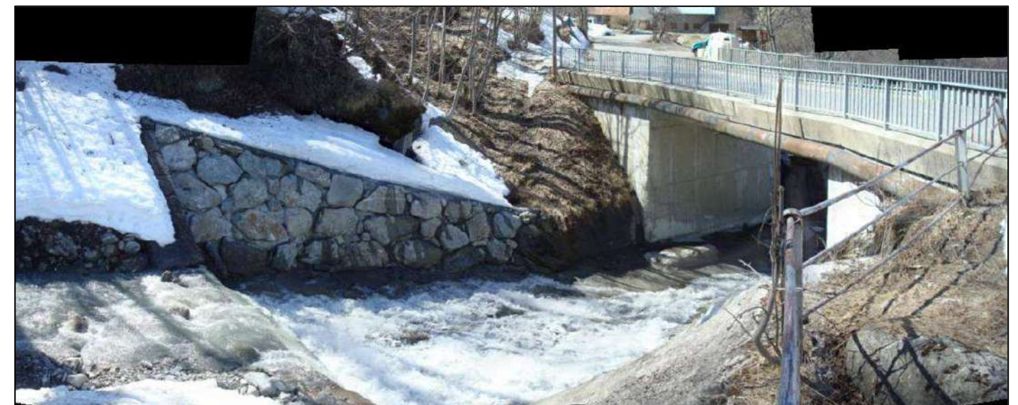
Seuil et pont de la RD 80
