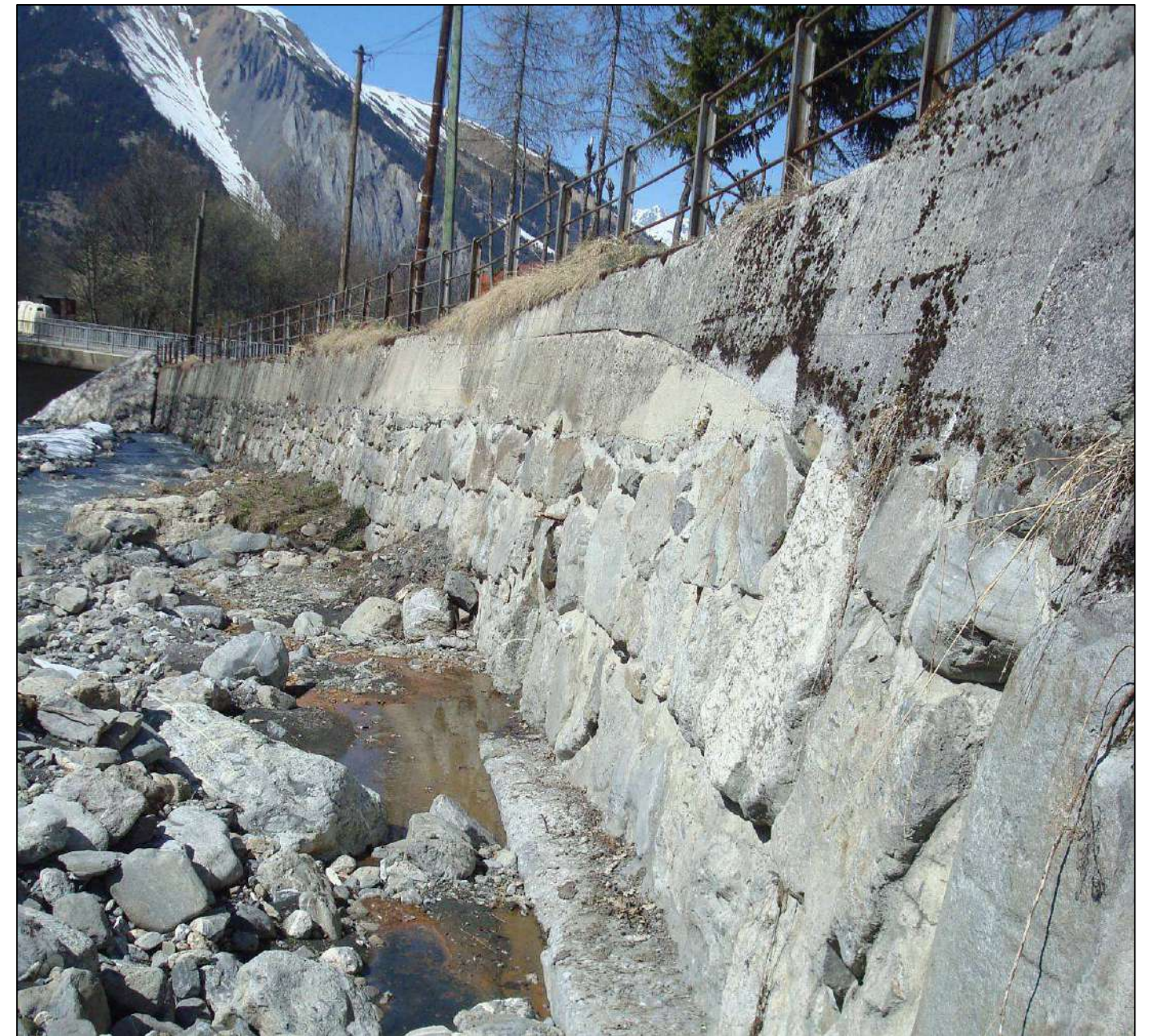
Berge rive droite en enrochements maçonnés, base renforcée - Traversée du village
