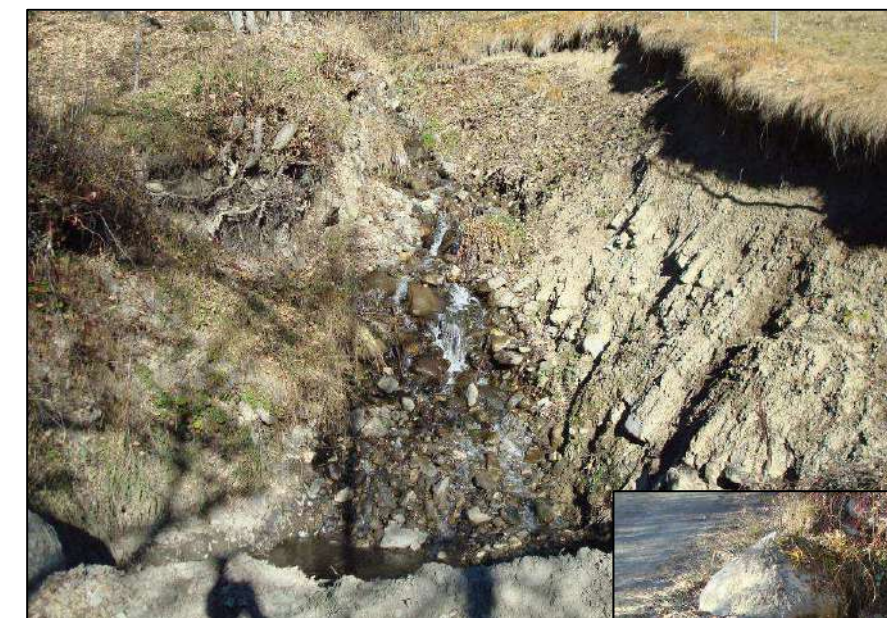
Débouché du torrent principal (C 3-5 ) en amont de la piste
