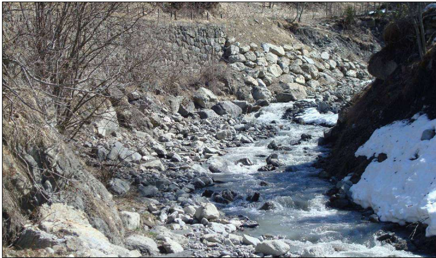
Enrochements secs et maçonnés dans le coude en amont du hameau
